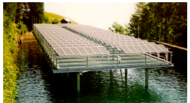
Fig 11.1.1: Ansicht der PV-Anlage Buchserberg/Vorderberg
