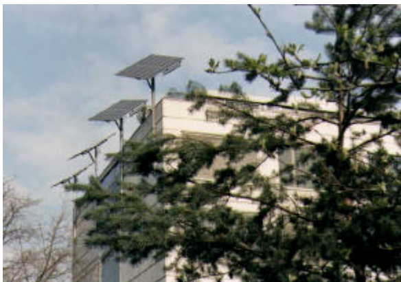
Fig 4.1.1.a: Ansicht der PV-Anlage NOK-Zentralverwaltung Baden, Aufbau bis 5. August 1998
