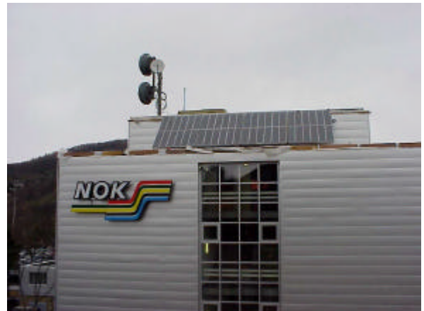
Fig 4.1.1.b: Ansicht der PV-Anlage NOK-Zentralverwaltung Baden, Aufbau ab Dezember 1998
