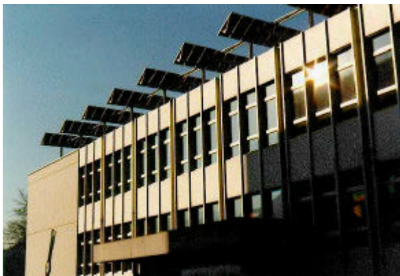
Fig 10.1.1: Ansicht der PV-Anlage Neu-Technikum Buchs (NTB)
